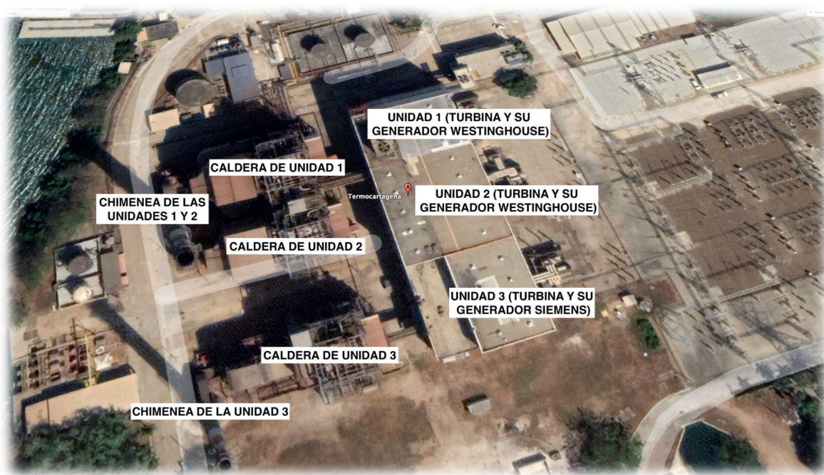
Ilustración 10. Vista satelital de las unidades que componen la planta Termocartagena
